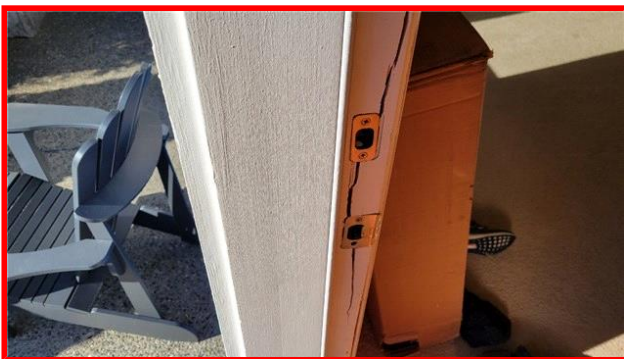
Broken Front Door Jamb
